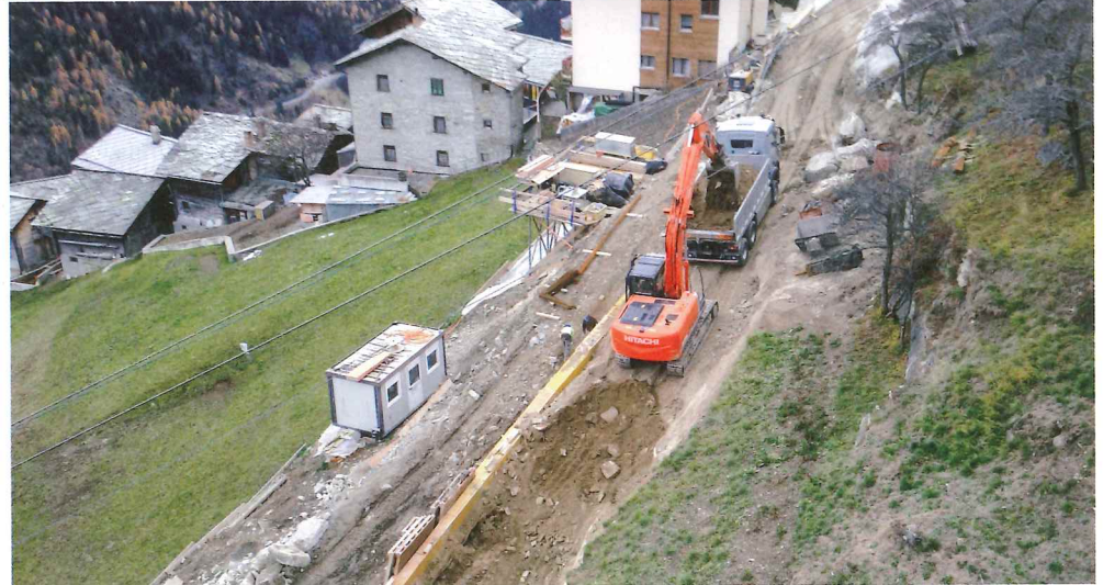
Die Arbeiten im steilen Gelände sind aufwendig und erfordern viel Fingerspitzengefühl.
